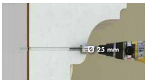
Agrandir légèrement l'entrée du trou afin de pouvoir placer ultérieurement une rondelle sur la tige filetée. La rondelle doit avoir un diamètre de 25 mm et venir en appui sur le polystyrène.
