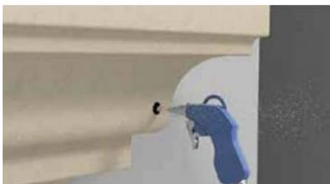
Envoyer de l'air sous pression dans l'orifice afin de chasser la poussière de ciment et de Polystyrène.
