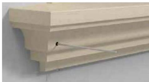
Tige en acier zingué inoxydable d'un diamètre de 12 mm et d'une longueur adaptée à la modénature.
