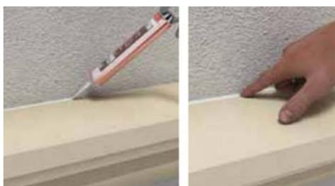
Une fois la colle sèche, afin d'éviter les infiltrations d'eau entre la modénature et le support il est impératif de déposer un cordon d'étanchéité avec le mastic DOMOSTYL® LM215 sur toute la périphérie de la moulure. Celui-ci sera immédiatement lissé au doigt et ne devra comporter aucune rupture.
